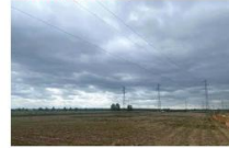
Coupage paysagère des lignes haute tension
