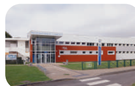
Bassin nautique de La Norville - CDEA chemin de la Garenne
